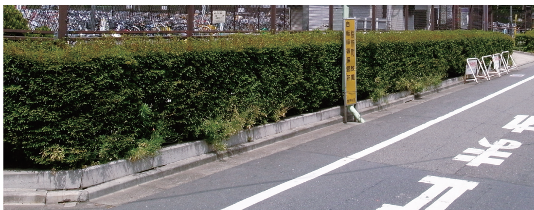
Ｌ字側溝が整備された他地区の道路の事例
