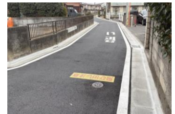
市道5305号線側溝整備工事
