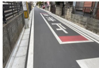
市道5304号線側溝整備工事
