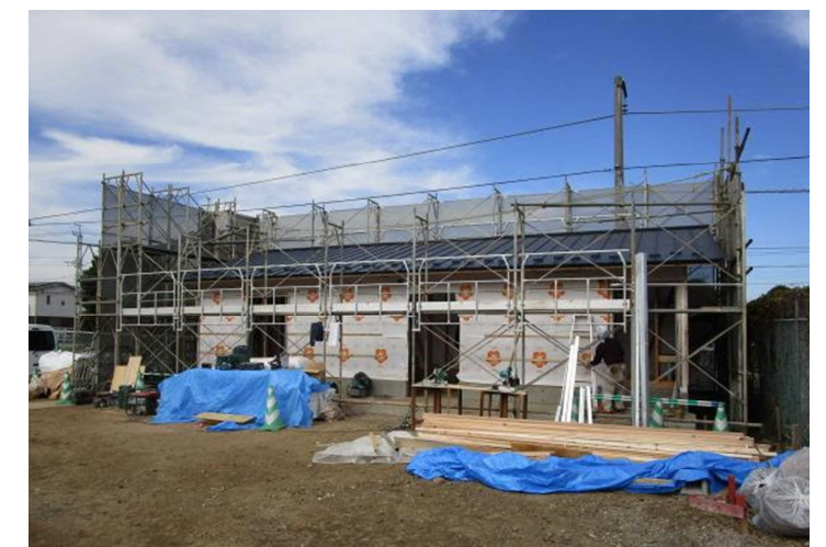
④公衆トイレの本体工事の様子です。 （平成30年11月撮影）
