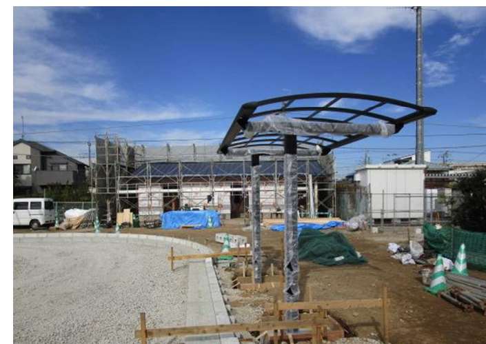
③シェルター設置の様子です。 （平成30年11月撮影）
