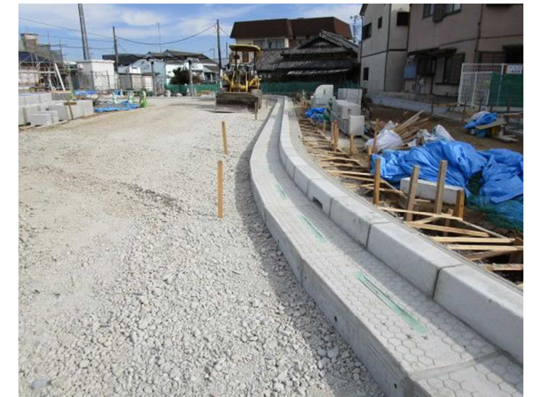
②駅前広場の側溝工事の様子です。 （平成30年11月撮影）
