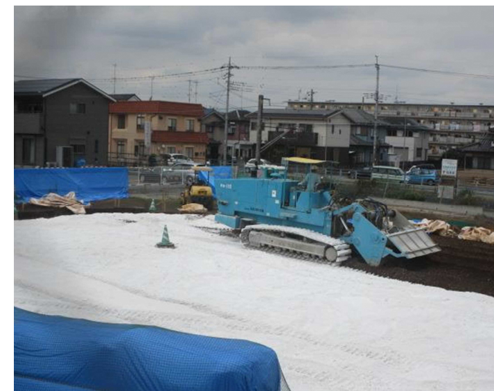
③道路地盤を改良している様子です。（平成30年10月撮影）
