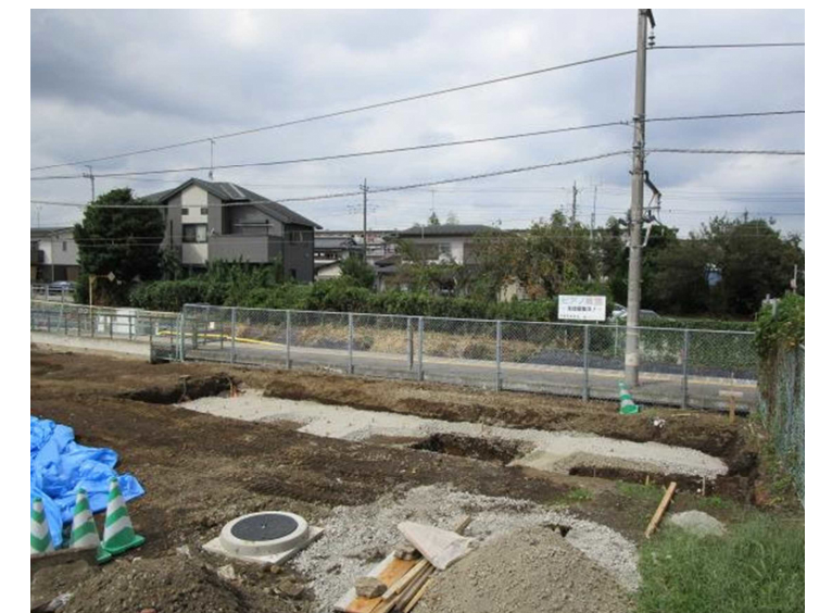
④公衆トイレの基礎工事の様子です。（平成30年10月撮影）
