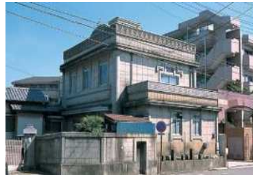
②片山家(景観重要建造物)
