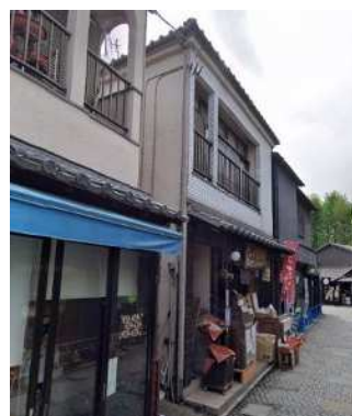
工事前の様子
