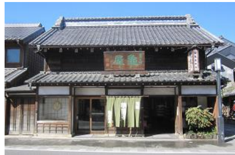
中島家住宅店棟（亀屋栄泉）
