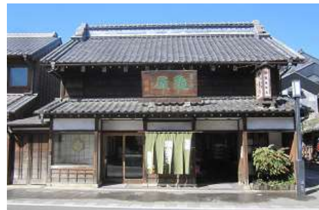
中島家住宅店棟（亀屋栄泉）
