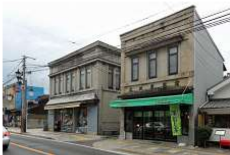
久保町通り（看板建築）
