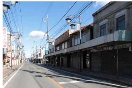
中央通り（看板建築）
