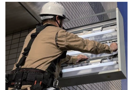
照明装置の劣化・破損を確認している様子
