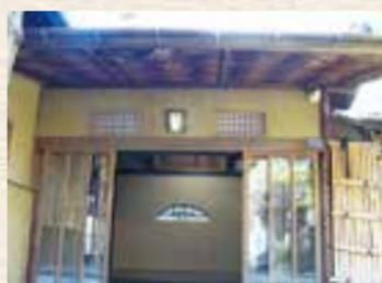
東京柳橋の料亭「二葉」の主人により、その建築の面影を残す造りで建てられました。杉皮葺き屋根の特徴的な玄関と寄棟屋根の純和風建築が、料亭のたたずまいを見せています。
