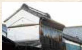
人造石洗い出し仕上げの洋風基調の外観は、大正時代の改修です。しかし骨組みは、明治の大火以前の杉皮葺き町家で、低い2階が特徴です。土蔵は白漆喰仕上げの文庫蔵で、主屋と一体となって大火以前の商家の様相を留めています。
