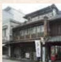
市内では数少ない木造3階建てです。上の階に行くにつれて道路より後退する屋根と壁面、小割に分割されたガラス戸、銅板葺きの屋根を支える細い垂木と薄い軒先などの繊細さが特徴です。
