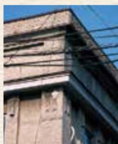
人造石洗い出し仕上げの重量感あふれる建築で、川越の代表的な洋風店舗です。庇と窓台で水平に分割し、窓枠と柱形によって垂直性が強調されています。柱上部や窓枠上部のレリーフも見逃せません。
