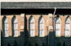
市内に残る唯一のレンガ造りの建築です。スレートを葺いた急勾配の屋根と、尖塔<sup>せんとう</sup>アーチ型の窓が垂直性を強調し、全体として中世ゴシック建築を思わせるデザインとなっています。
