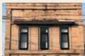
人造石洗い出し仕上げの洋風店舗です。パラペットが特徴的で、編状の仕上げになっています。また、曲面を用いた笠木や曲線を多用するレリーフなど、全体的にやさしい感じに仕上がっています。
