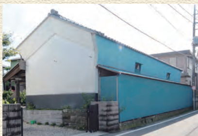
江戸時代末建築 (推定) 景観重要建造物
