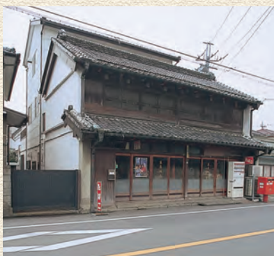
大正8年建築 景観重要建造物 令和5年修理
