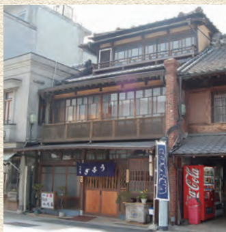
大正13～14年頃建築 平成15年・25年修理 景観重要建造物
