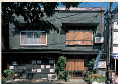
昭和4年頃建築 都市景観重要建築物
