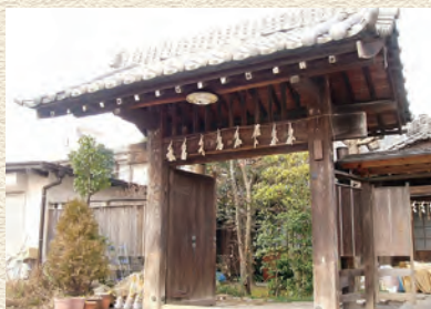
江戸後期建築 景観重要建造物
