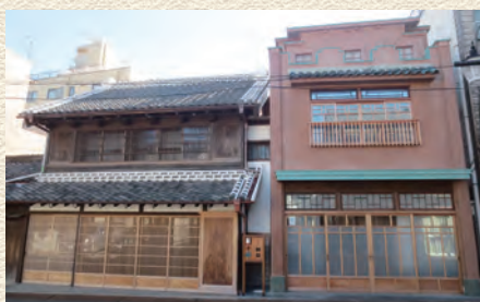
主屋(左): 川越大火後の建築(推定) 袖蔵(右): 明治26年建築 土蔵:明治13年建築 景観重要建造物 平成28・29年修理 令和3年度 都市景観賞
