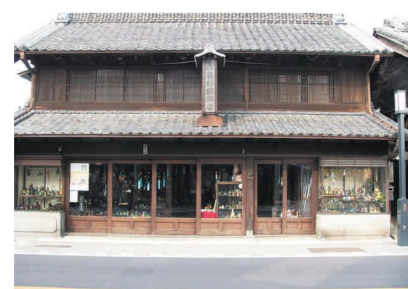
真壁造り町家(荻野家住宅)
