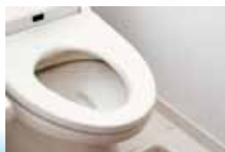
トイレのつまり・水漏れ
