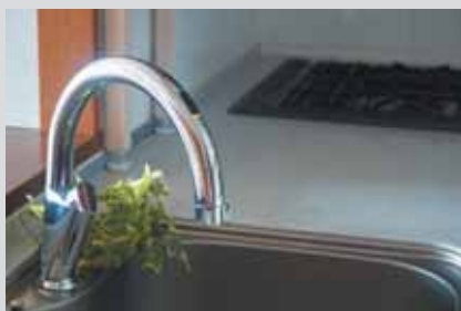
蛇口の水漏れ
