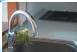
蛇口の水漏れ
