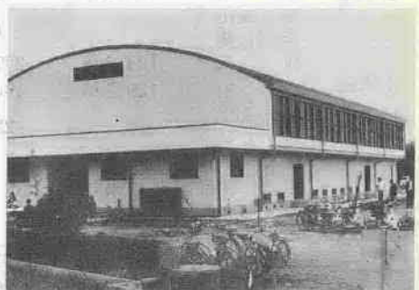
完成した大東中体育館。このほか城南中、福原小・中共用体育館も完成しました。
