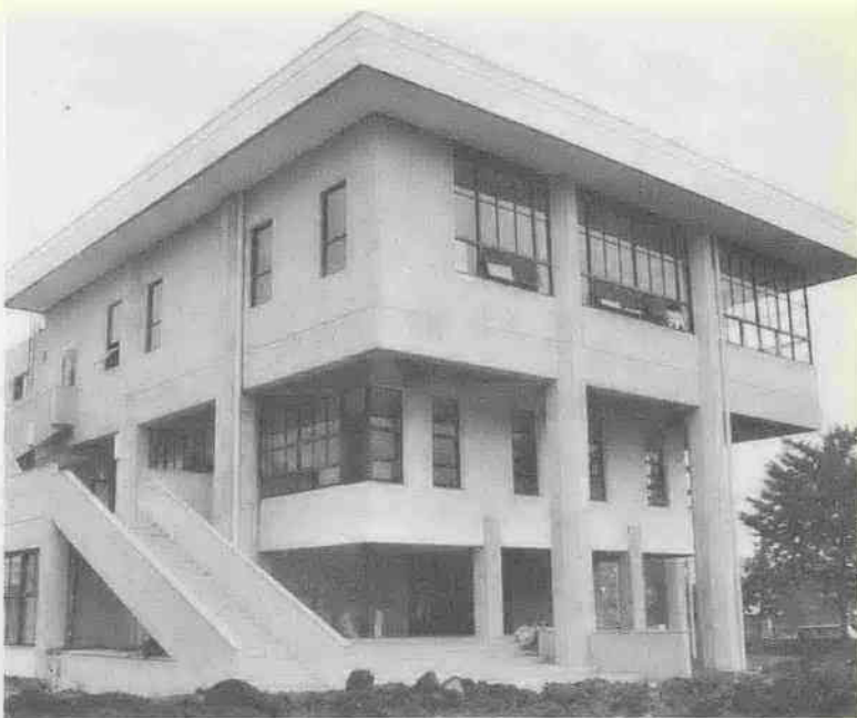
〈完成した中央公民館〉
