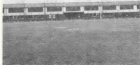
請 願 さ れ た 富 士 見 中 学 校
