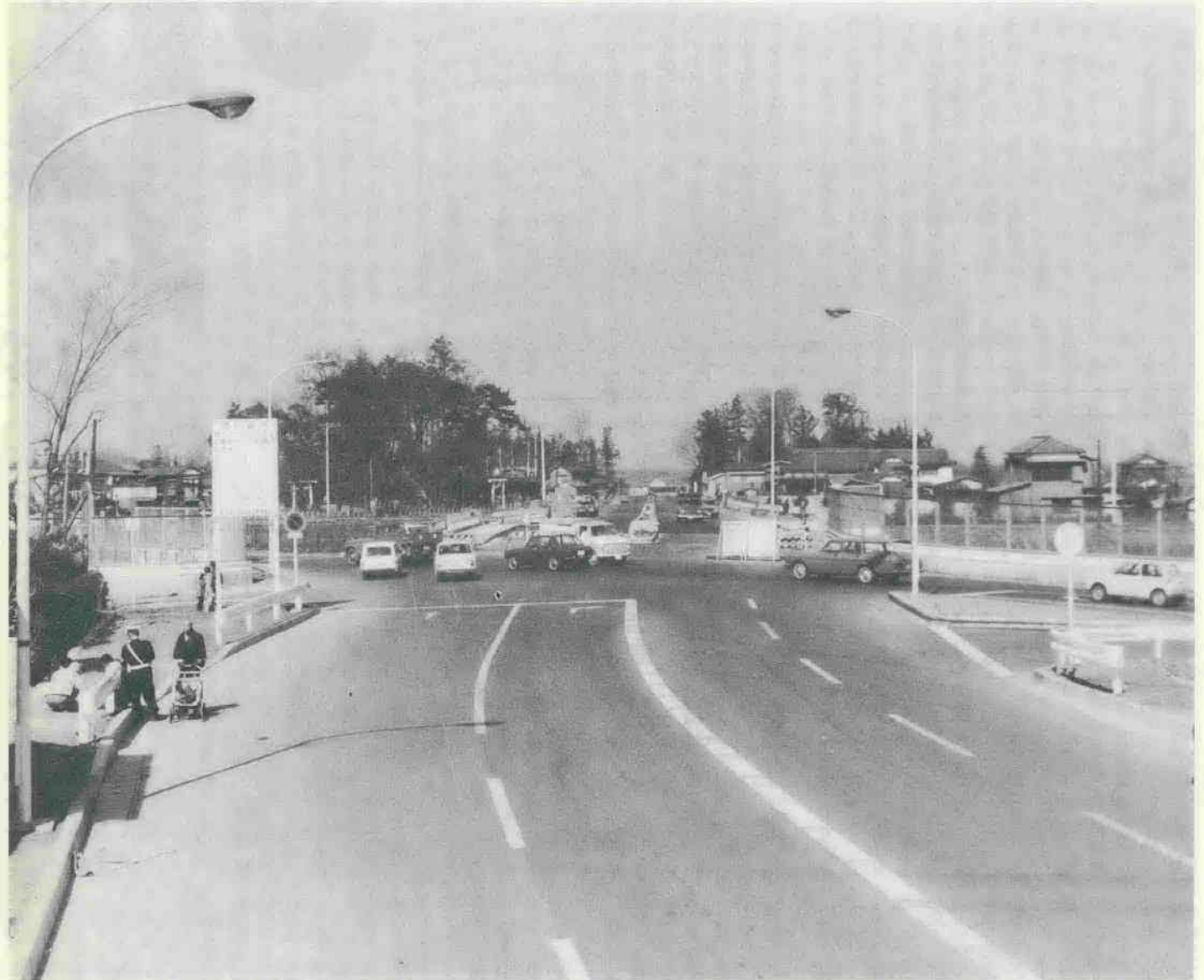
完成間近かな南バイパス(うとう坂付近)
