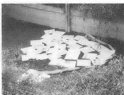
油吸着用マットで油を除去する様子
