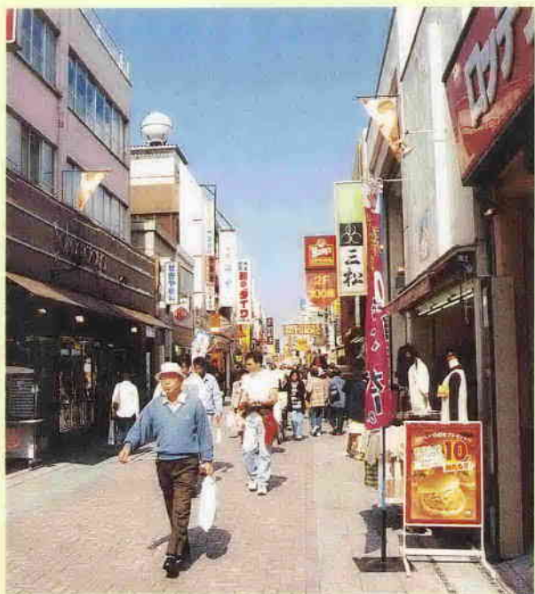
電線類地中化工事が終了するクレアモール
