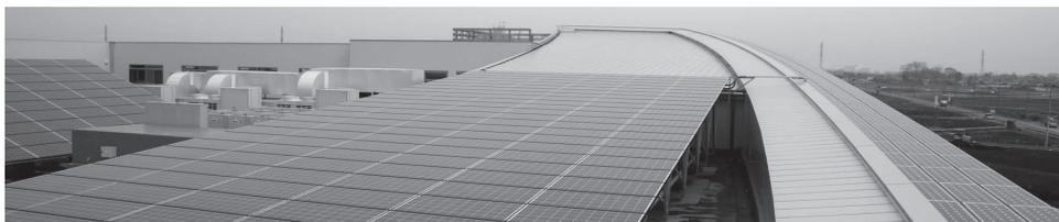
つばさ館屋上の太陽光発電設備。草木類資源化施設と合わせて約167kWの発電容量です
