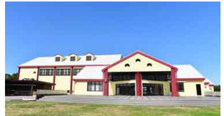
グリーンツーリズム拠点施設
