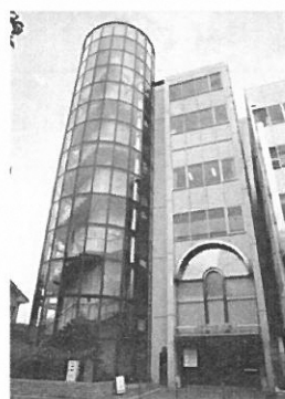
川越駅東口図書館
