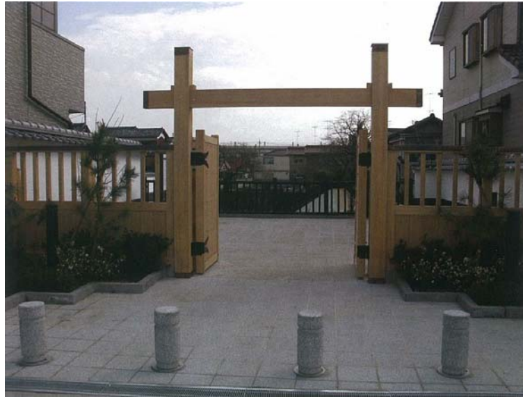
図 中ノ門堀跡・入口の冠木門
