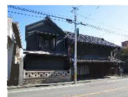
景観重要建造物 足立勝(あだかつ)(原田家)
