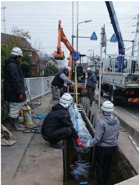
水道管布設工事
