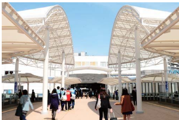
川越駅西口駅前広場
