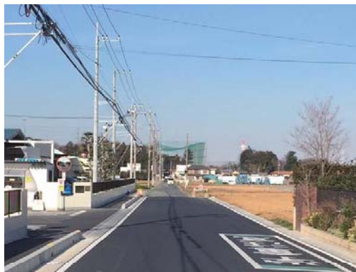
拡幅整備中の幹線道路（市道 0058 号線）
