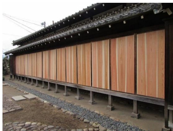
修理後 雨戸を新規の杉板に張り替え
