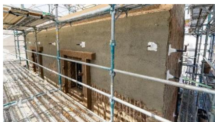
砂摺り(荒壁を平らにする)
