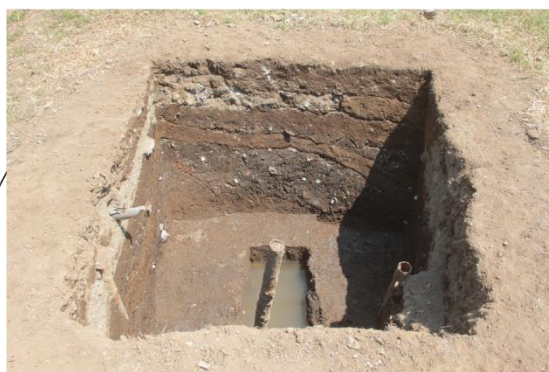
トレンチ掘削状況 (北西から)
