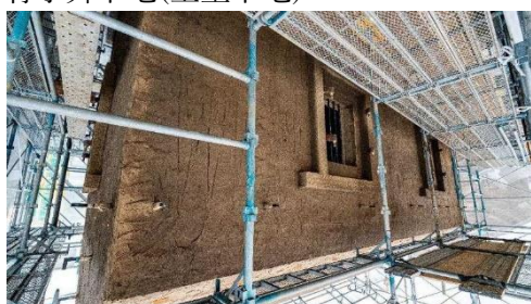
荒壁(表塗り)乾燥養生
