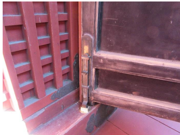
修理後 正面棧唐戸の固定金具の設置
