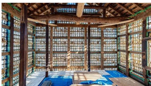
竹小舞下地(土壁下地)
