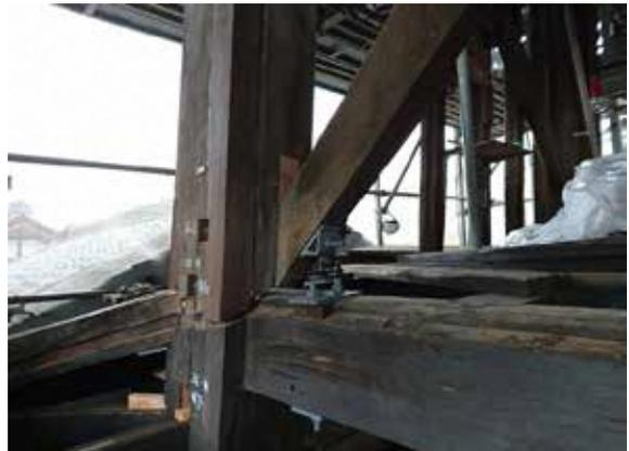
主柱・梁・筋違接合部の引きボルト
