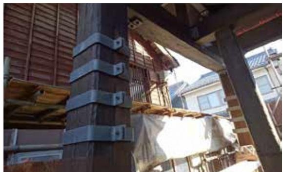
素屋根解体後、主柱根継ぎ部分の補強金輪取付
