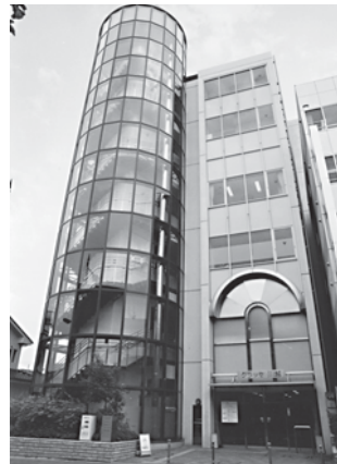
川越駅東口図書館
