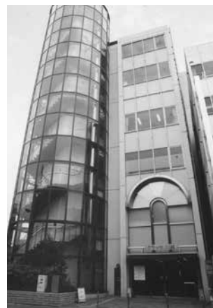
川越駅東口図書館
