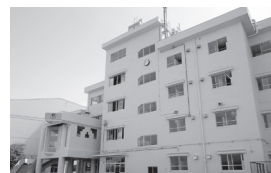
平成27年度に大規模改造工事を実施した牛子小学校
