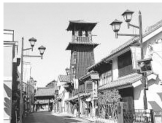
平成28年度に耐震化工事が完了した時の鐘
