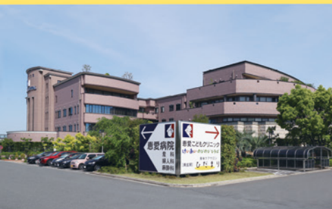
恵愛病院全景/駐車場250台
