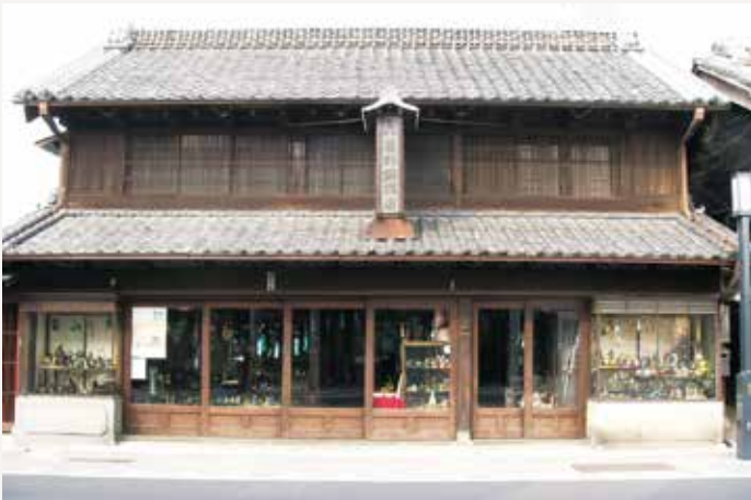
真壁造り町家（荻野家住宅）
