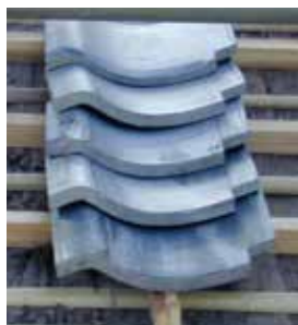
下地を木枠でふかす
