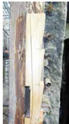
柱の縦半断面継ぎ
