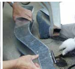
樋の集水器（あんこう）の加工
