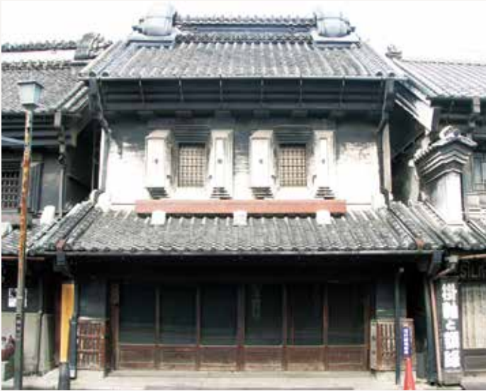
蔵造り町家（宮岡家住宅）
