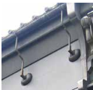
鍛鉄による樋金物
