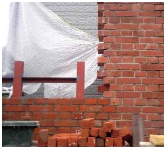
イギリス積みのレンガの防火壁
