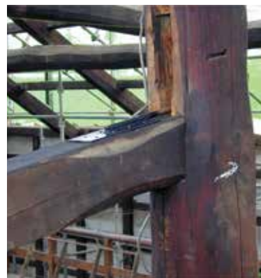
既存繫ぎ梁、柱との接合部羽子板金物補強
