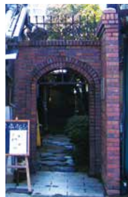
レンガ塀の設置例
