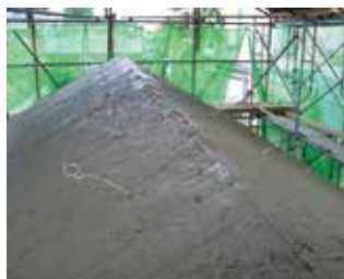
屋根の修理（葺土の状態）
