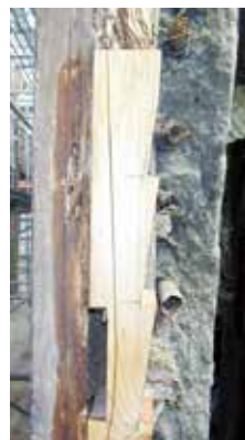
柱の縦半断面継ぎ
