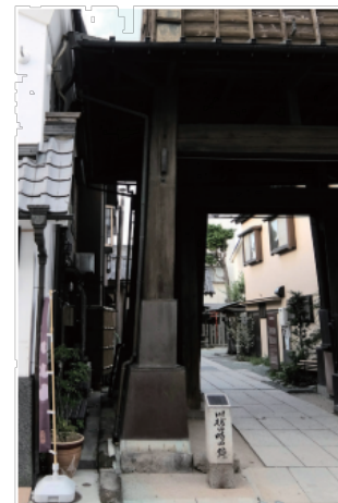
復原前（独立コンクリート基礎）
