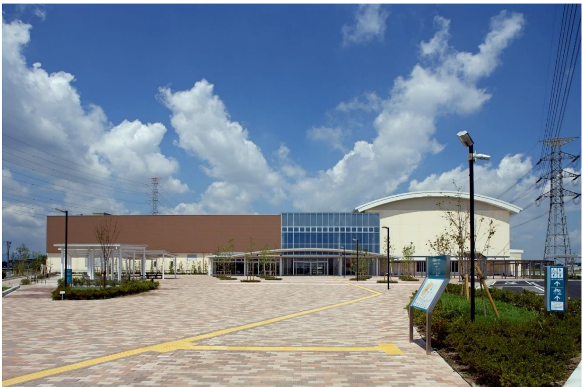
なぐわし公園 PiKOA（余熱利用施設）正面外観
