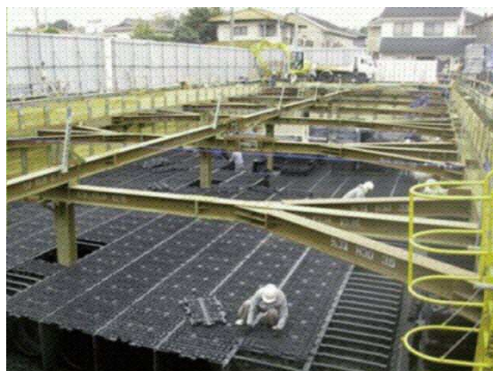
雨水貯留施設の整備
