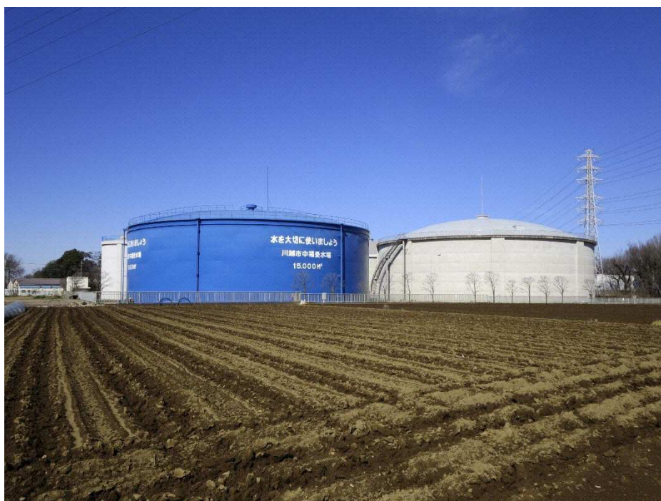
中福受水場配水池
