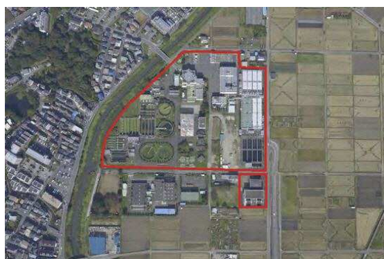
新河岸川上流水循環センター
