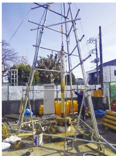
井戸修繕の様子
