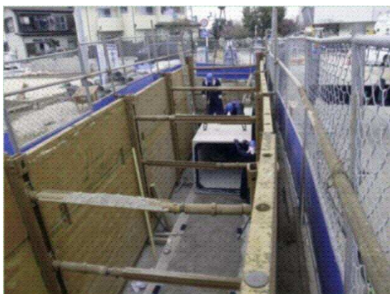
雨水管きよの整備
