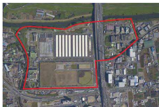
新河岸川水循環センター
