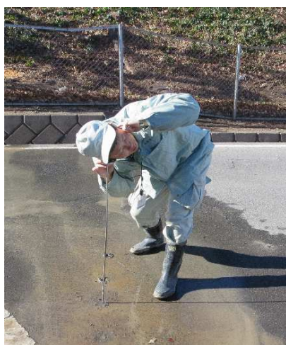
音聴棒を使った漏水調査
