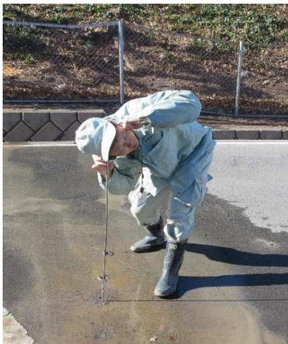
音聴棒を使った漏水調査
