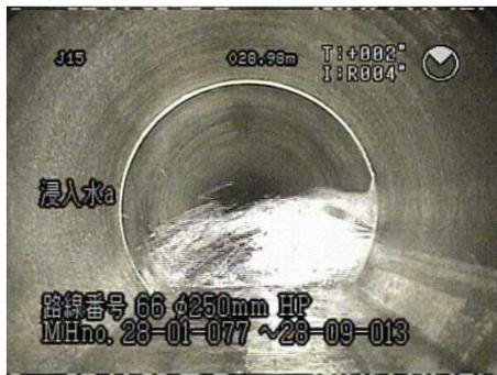
継手からの地下水の流入（管内調査）
