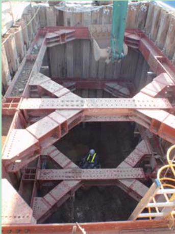
はっしんたてこう (左)発進立坑掘削の様子
