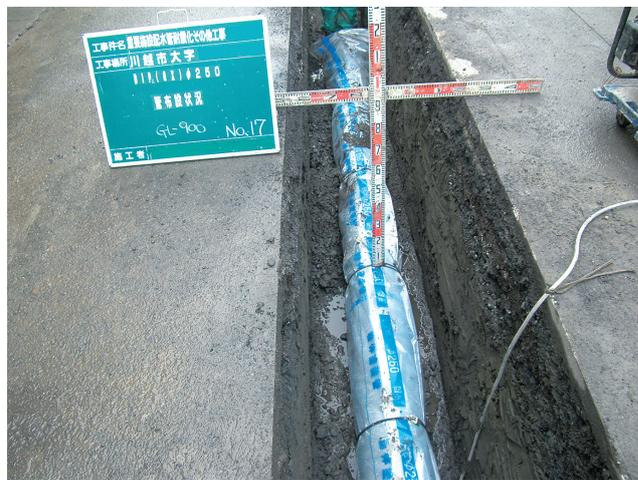
右の写真は、配水管を実際に布設している様子です。耐食性の高いダクティル鉄管に、さらにポリエチレンスリーブを巻いて腐食を防止することにより、100年以上の長寿命化が期待されます。
