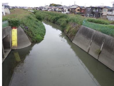
樋門より上流側
