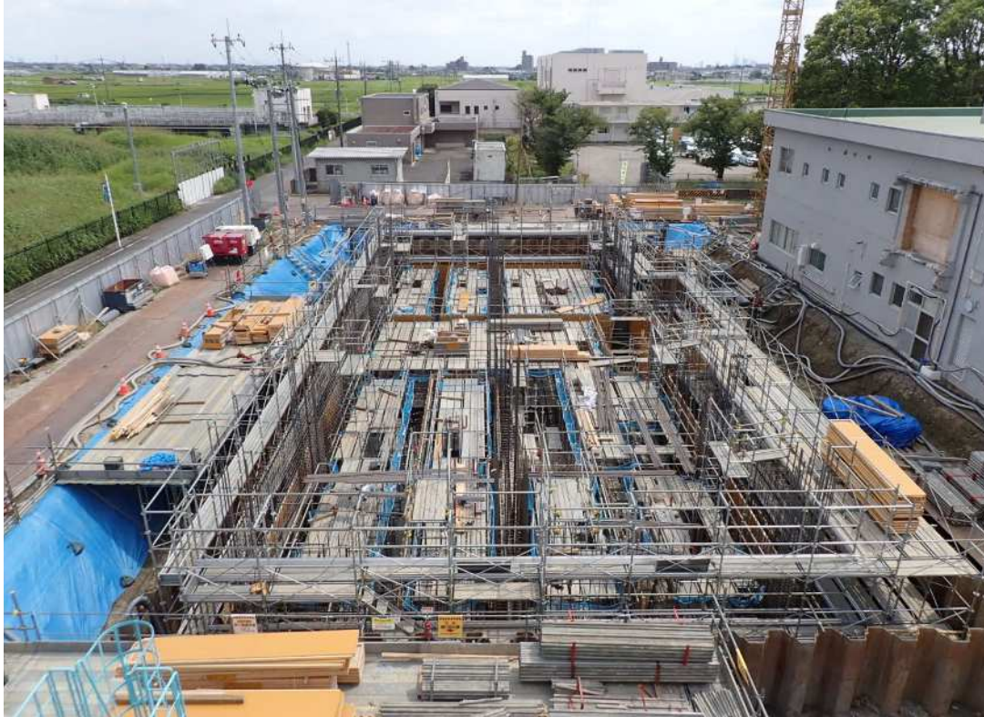
地下躯体工事を実施しています。
