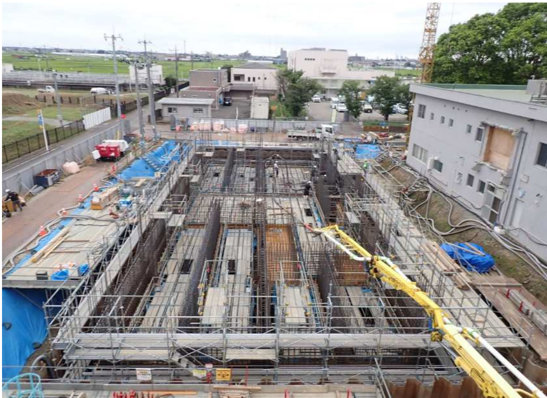
地下躯体工事を実施しています。
