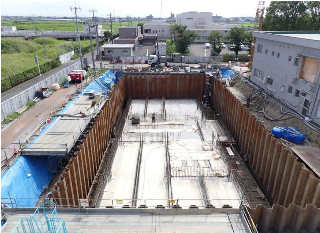
基礎工事を実施しています。
