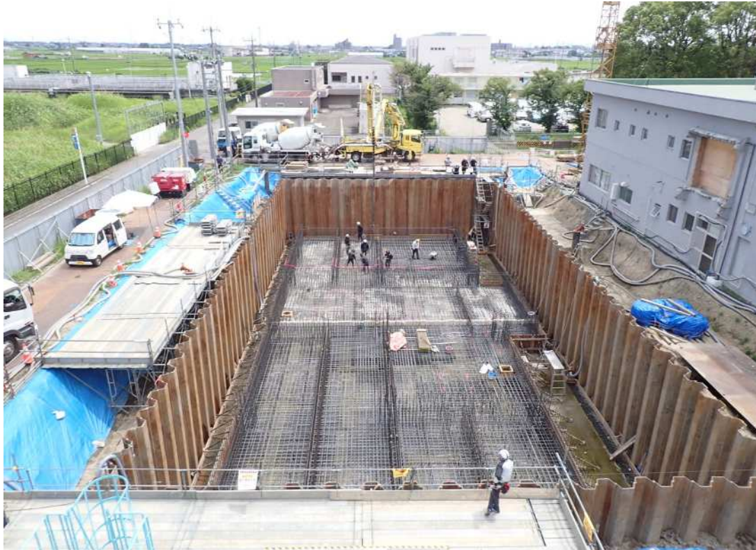
基礎工事を実施しています。
