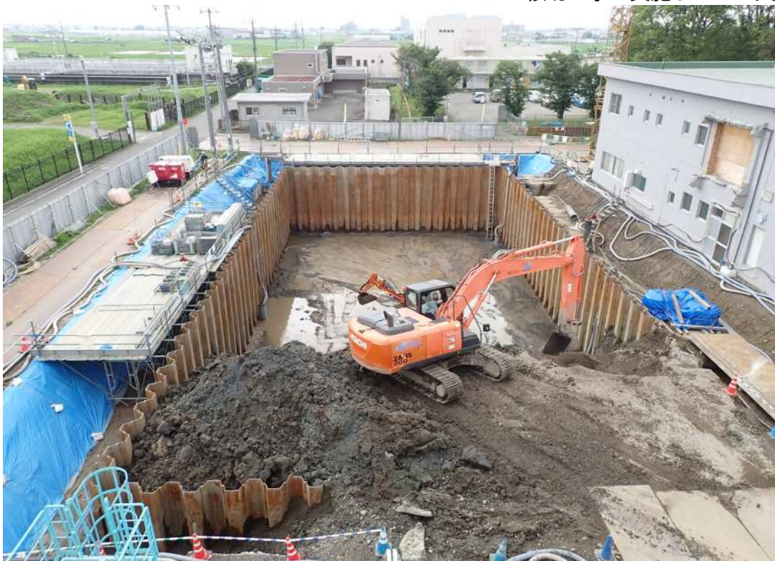
根切工事を実施しています。
