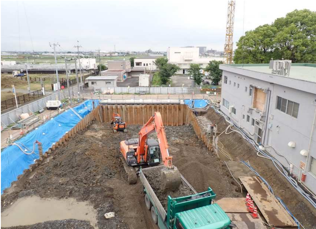
根切工事を実施しています。
