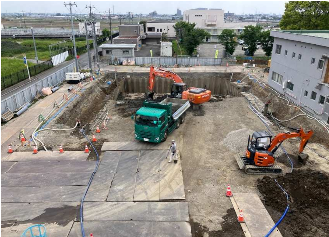
根切工事を実施しています。
