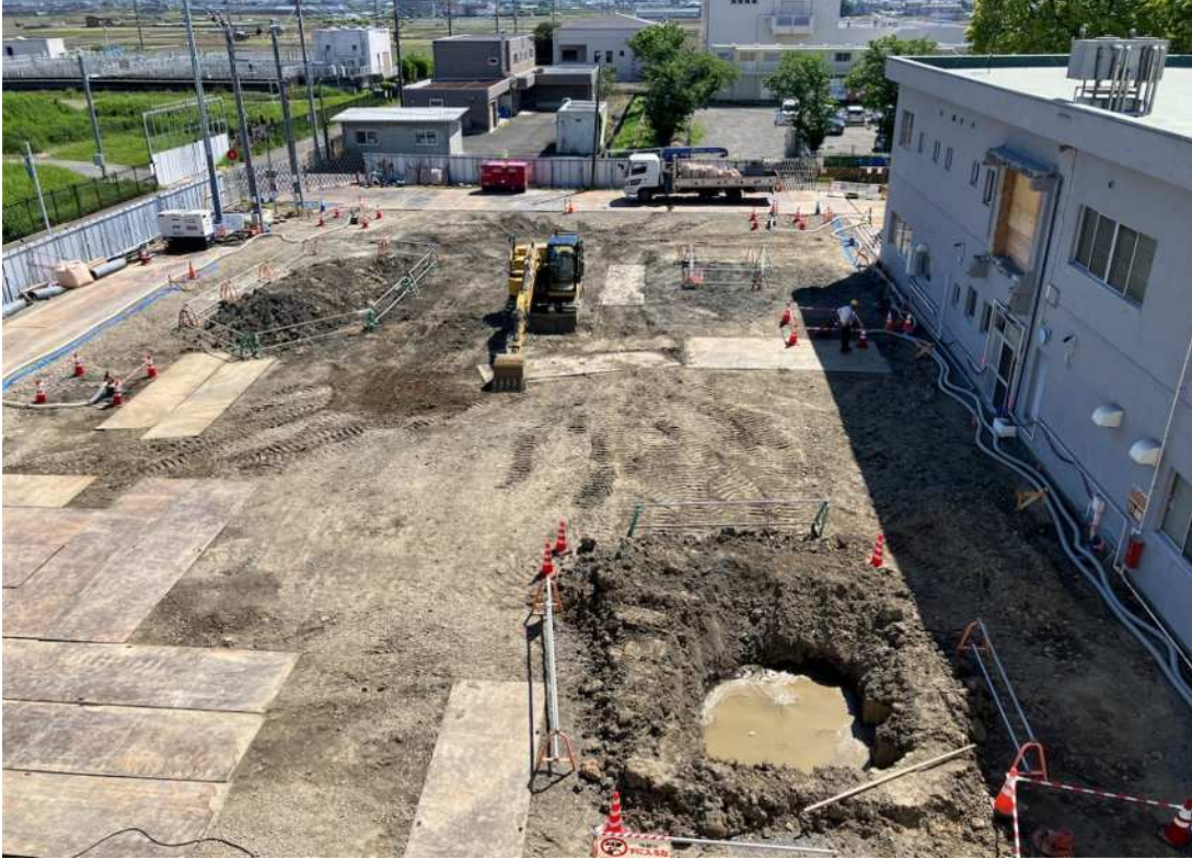
地下水対策工事が完了しました。
