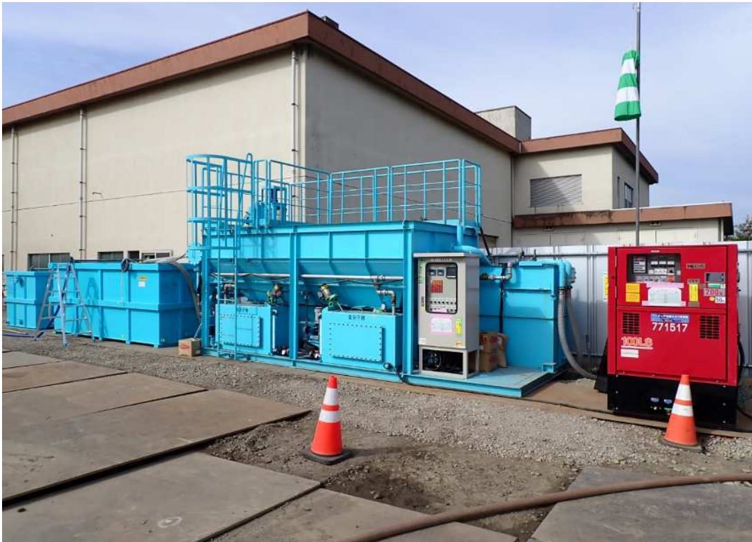
濁水処理装置を設置しました。
