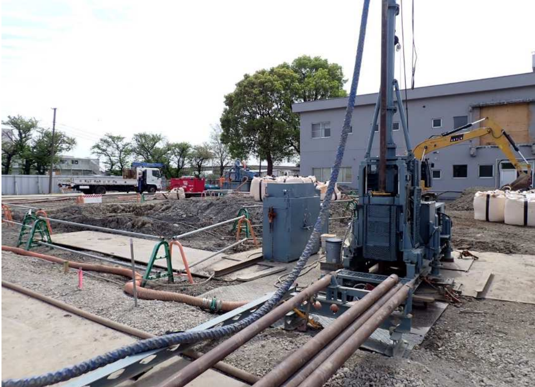
地下水対策工事を実施しています。
