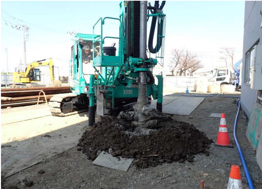
地盤改良工事が完了しました。
