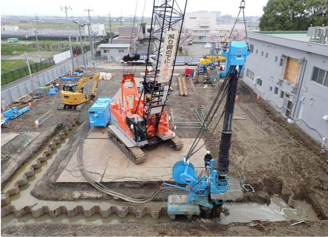
土留工事が完了しました。
