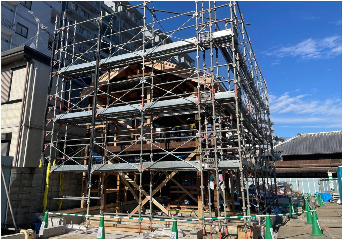
旧栄養食配給所住宅棟の建方工事
