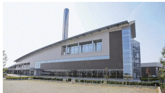
環境プラザ「つばさ館」
