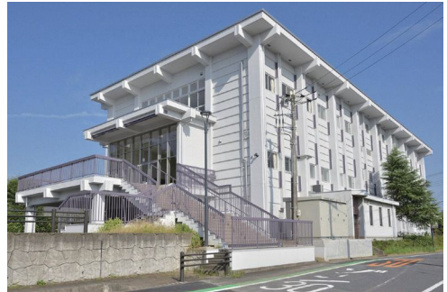
耐震改修後の武道館
