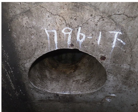
污水管きよ更生工事（施工前）
