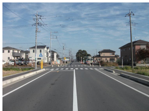
拡幅中の広域幹線道路 （市道0023号線）
