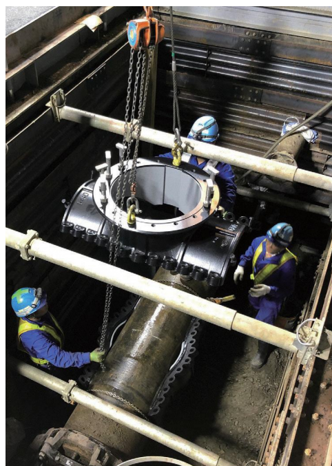
不断水バルブの設置工事
