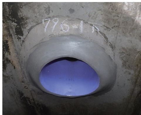
污水管きよ更生工事（施工後）
