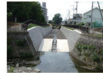
久保川・不老川合流 地点(整備後)
