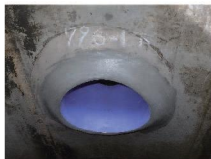
污水管きよ更生工事 (施工後)
