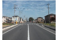
拡幅中の広域幹線道路 (市道0023号線)
